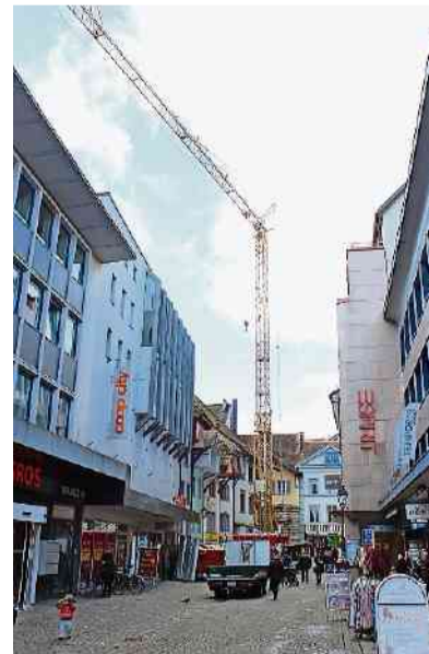
In der Igelweid steht der Kran. NRO
